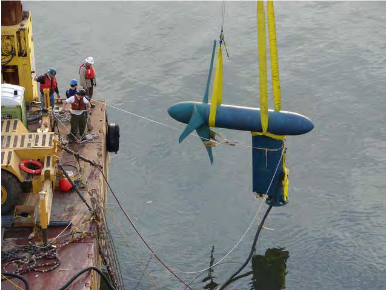
Turbina hidrocinética Verdant Power 35kW (Sale et al. , 2009)
